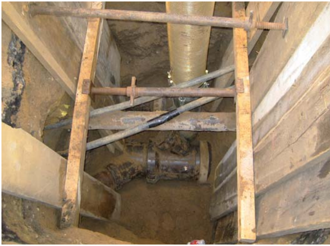
Mit dem Saugbagger absaugen ...
