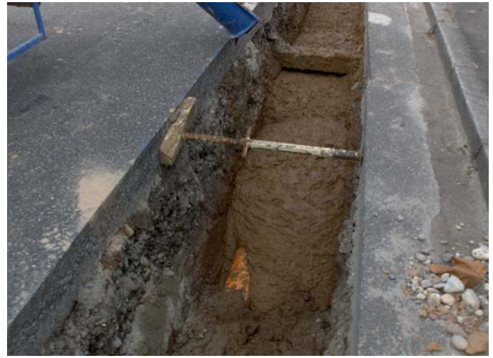
... und mit Flüssigboden verfüllen.
