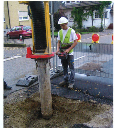
Saugbagger im Einsatz.
