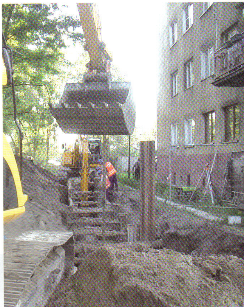
Fot. 1 Realizacja robót kanalizacyjnych w bezpośredniej bliskości budynku.
