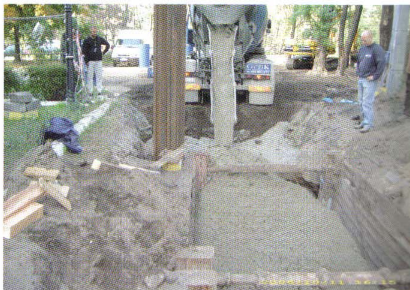
Fot. 3 Wypełnianie wykopu przy użyciu czasowo uptynionego gruntu
