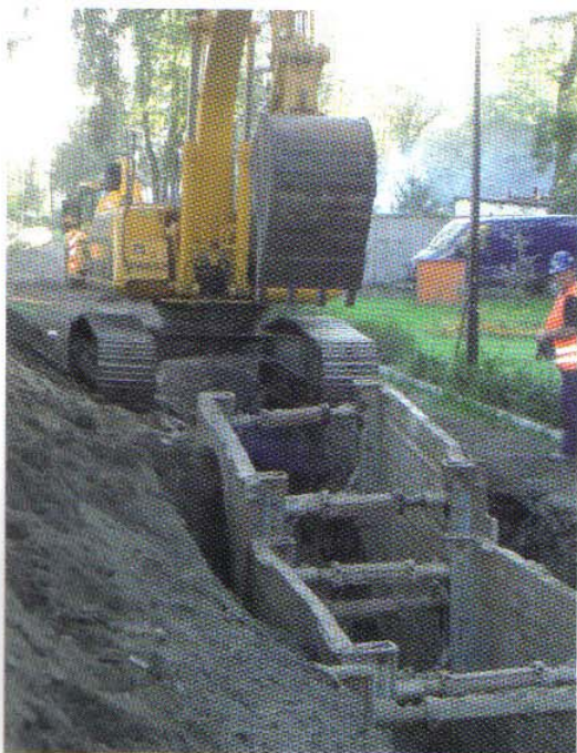
Fot. 2 Szerokość wykopu została zmniejszona do niezbędnego minimum
