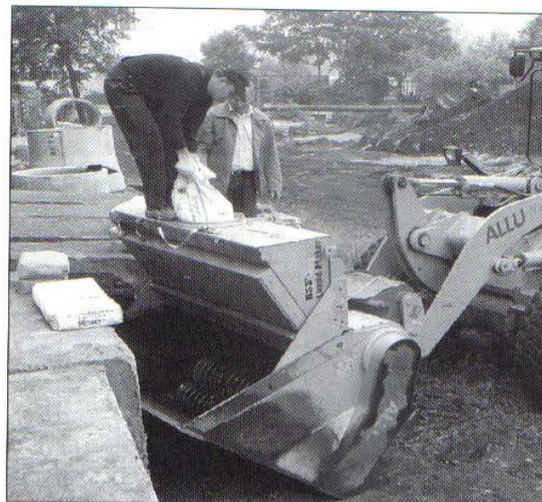
Fot. 2. Wprowadzanie środka wspomagającego – reagentu (tu ze względu na małą objętość gruntu – bezpośrednio do łyżki)
