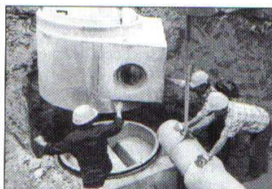
Fot. 5. Montaż segmentów studzienki rewizyjnej w systemie RSS
