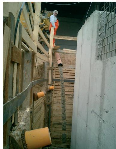
Einbau von RSS Flüssigboden® ohne Entmischung
