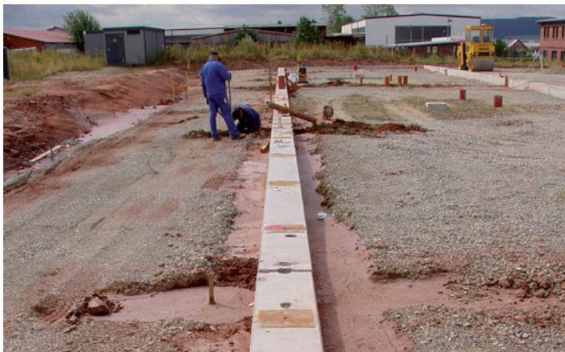
RSS Flüssigboden® Streifenfundamente setzungsfrei verfüllt
