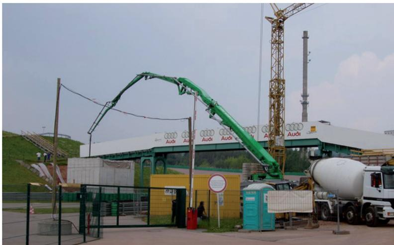
Einbau von RSS Flüssigboden® per Mastpumpe
