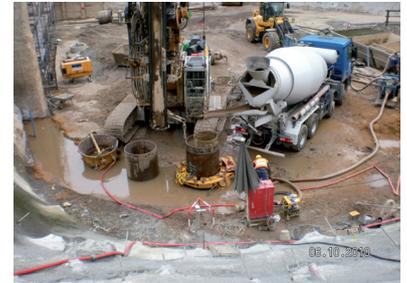
Bohrrohre werden mit RSS Flüssigboden® verfüllt
