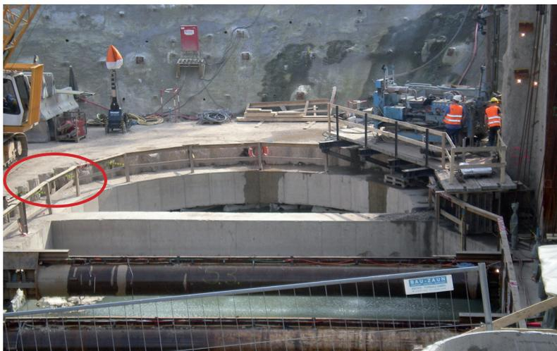
aus mit RSS Flüssigboden® verfüllten Bohrpfählen erstellte Bergungsgrube
