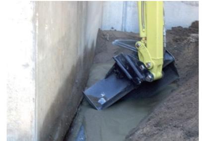
Einbau von RSS Flüssigboden®
