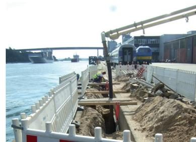
Verfüllung von Hohlräumen mit RSS Flüssigboden® hinter einer Spundwand
