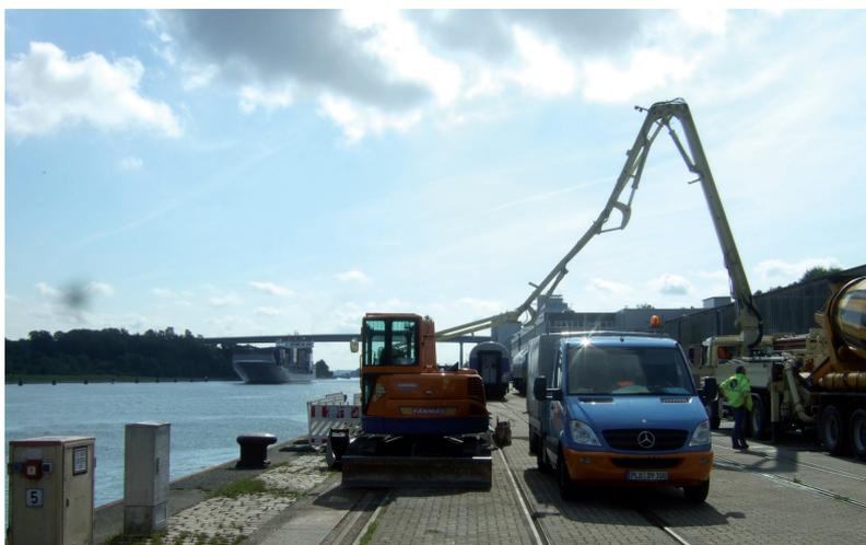
für das Pumpen optimierter RSS Flüssigboden® wird eingebracht
