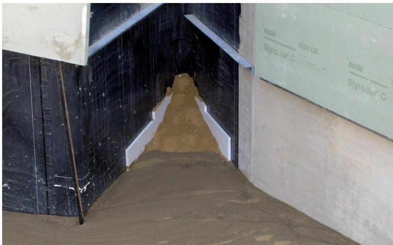
Hinterfüllung schwer zugänglicher Stellen mittels RSS Flüssigboden®
