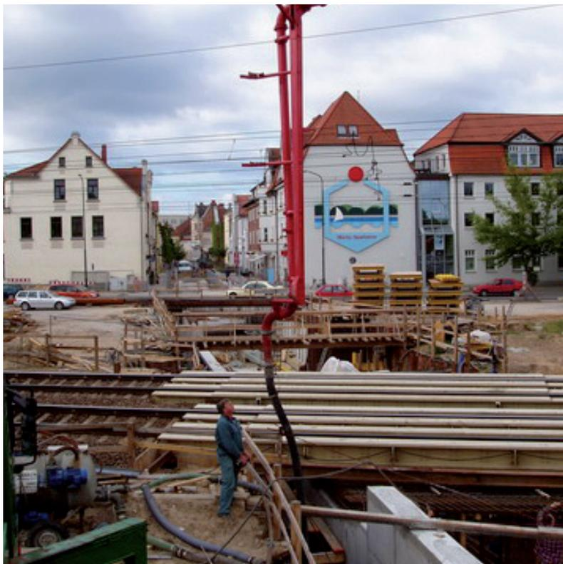
Einbau per Mastpumpe im Bereich einer Behelfsbrücke
