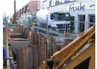
Einbau von RSS Flüssigboden®
