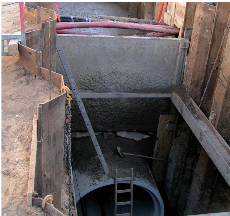
stark verkürzte Baustelle durch die RSS Flüssigboden® - Bauweise
