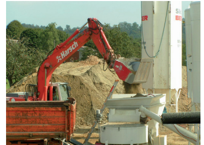
Herstellung von RSS Flüssigboden® auf der Baustelle
