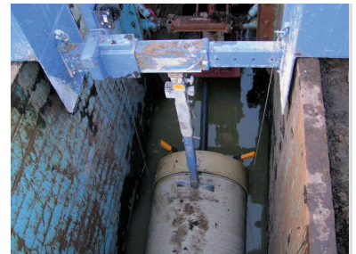
Lagefixierung mit RSS Systemtechnik
