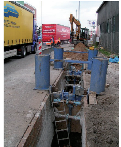
keine Behinderungen durch die Baustelle
