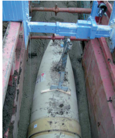
Verfüllung des Rohrgrabens mit RSS Flüssigboden® und dabei Verdrängung des darin befindlichen Wassers
