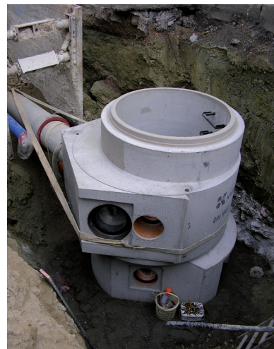
speziell für die Anforderungen konstruierter und gefertigter RSS Kombischacht
