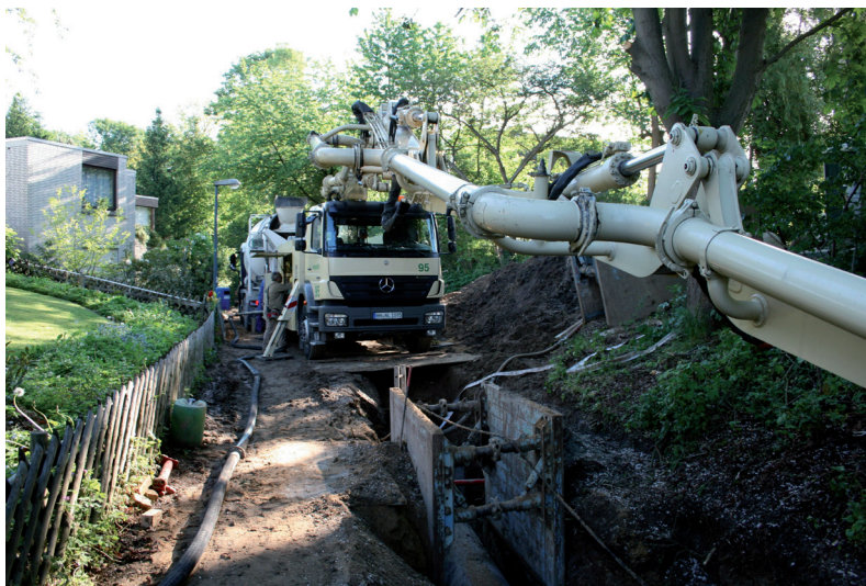
Verfüllung mittels Mastpumpe mit RSS Flüssigboden®
