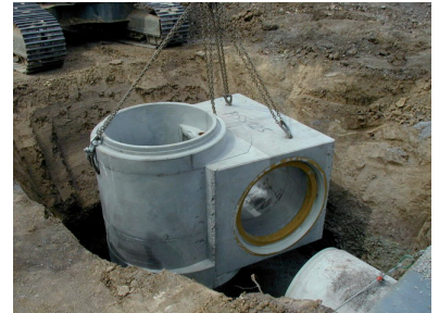
Setzen eines RSS Kombischachtes
