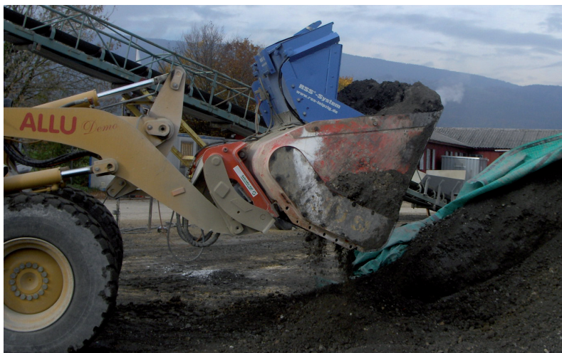
Aufbereitung des Aushubs für die Herstellung von RSS Flüssigboden®
