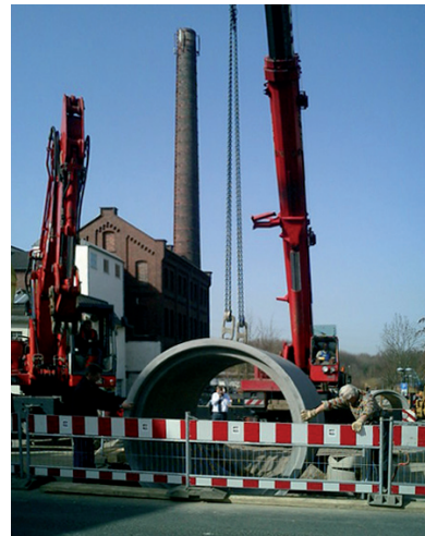
Einheben des Großrohrs DN 2.000
