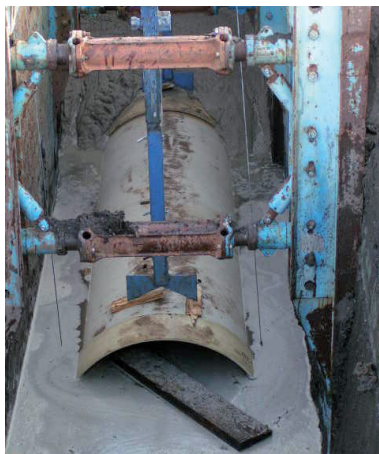
Verfüllung des Rohrgrabens mit RSS Flüssigboden® und dabei Verdrängung des darin befindlichen Wassers
