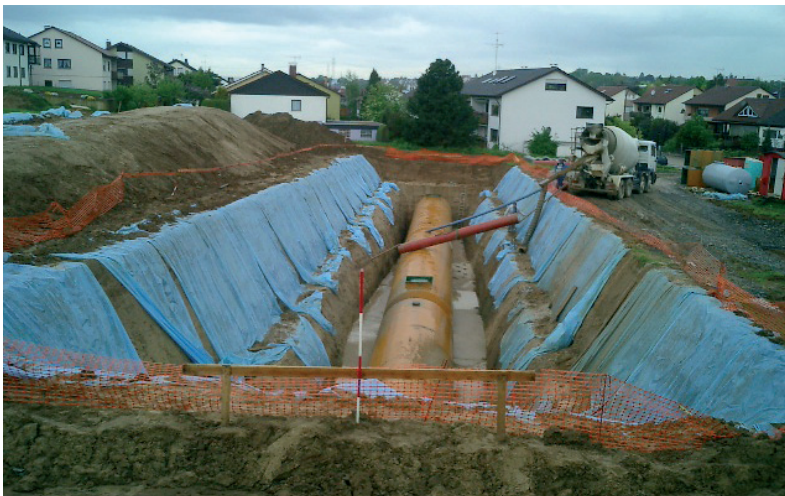
Verfüllung mit RSS Flüssigboden®
