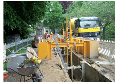
platzsparende Baustelle durch schmale Trasse
