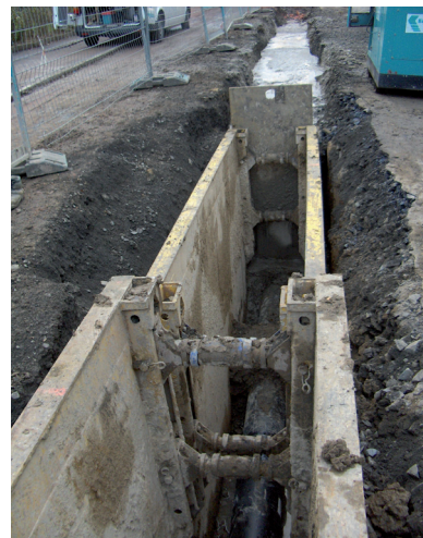
Schmale Gräben dank RSS Flüssigboden®
