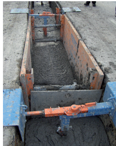
Wiedereinbau als RSS Flüssigboden®
