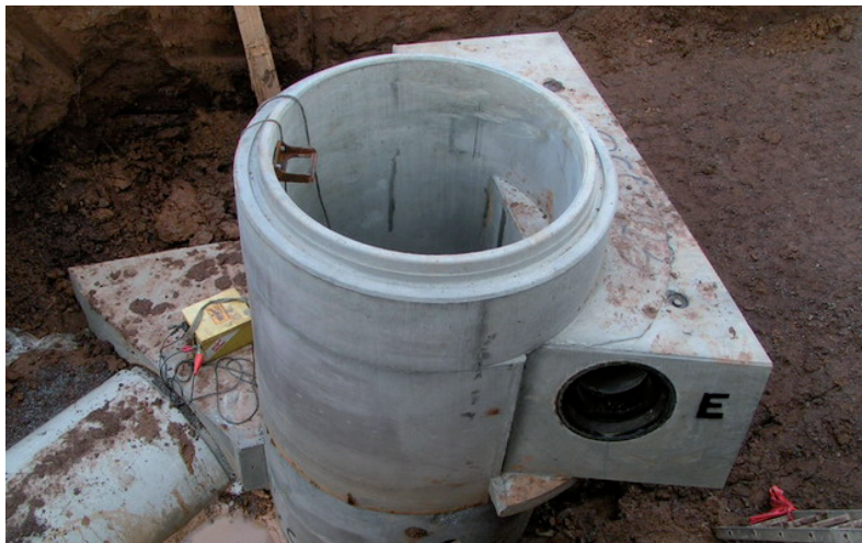
Verfüllung des RSS Kombischachtes mit RSS Flüssigboden®
