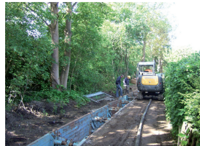
Vorbereiteter Leitungsgraben
