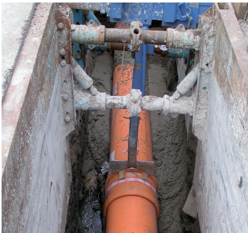
schwimmende Rohrverlegung in RSS Flüssigboden®
