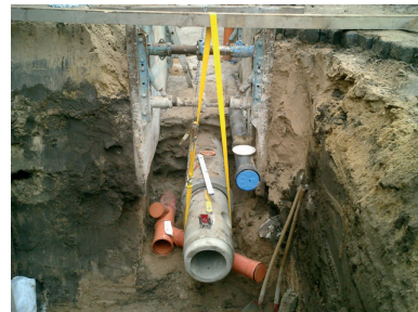
Komplexe Verlegesituation - ideal für RSS Flüssigboden®
