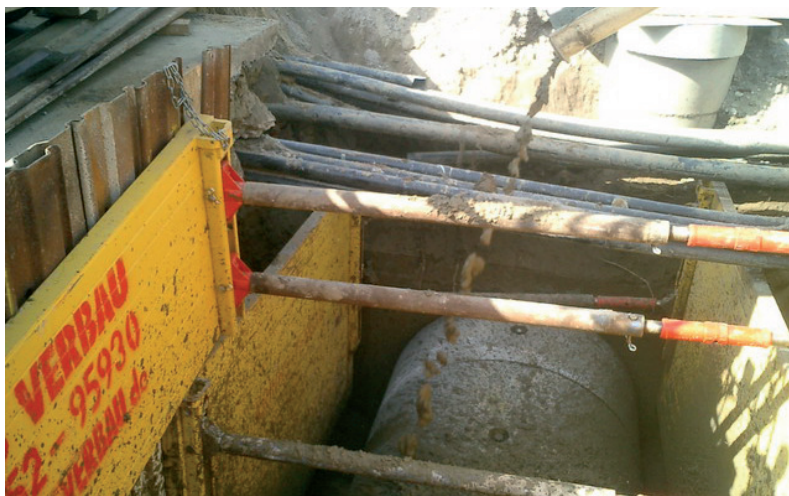
Rohrbettung in RSS Flüssigboden®
