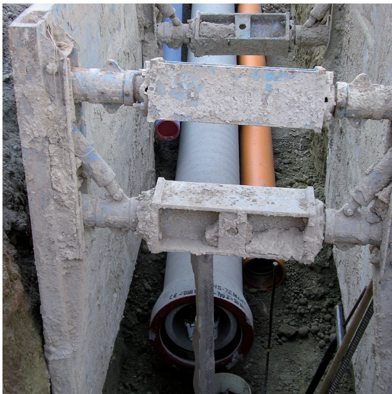
Rohrverlegung bei minimaler Grabenbreite in RSS Flüssigboden®
