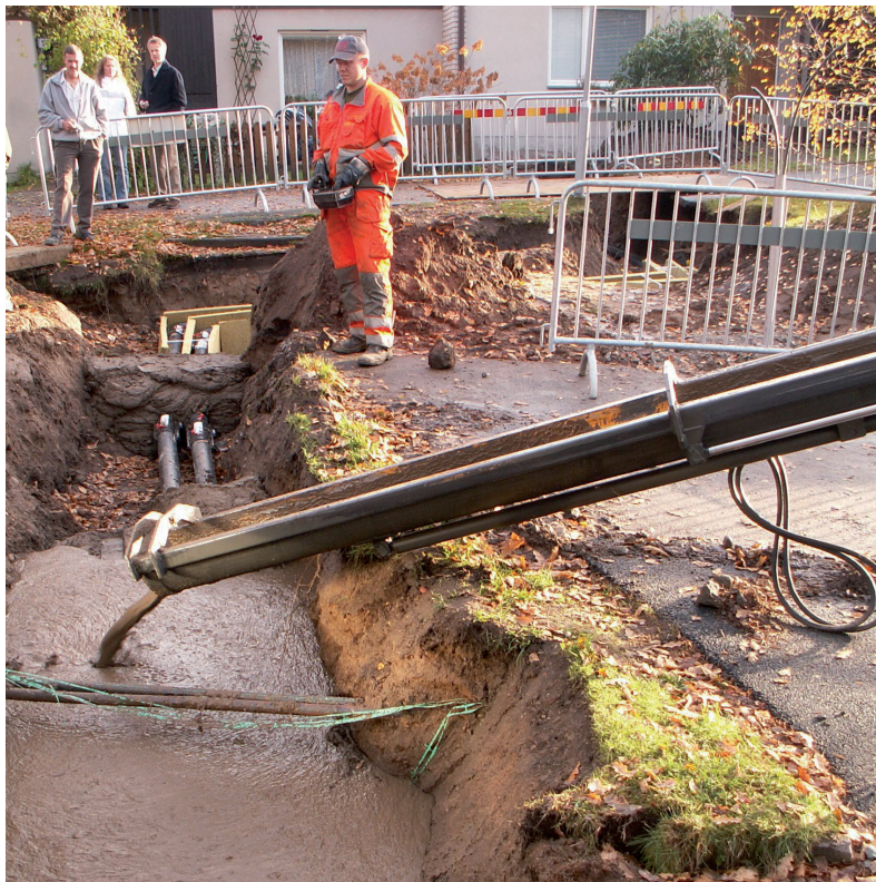
Verfüllung der Kunststoffmantelrohe mit RSS Flüssigboden®
