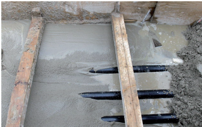
Verfüllung von Elektroleitungen mit RSS Flüssigboden®
