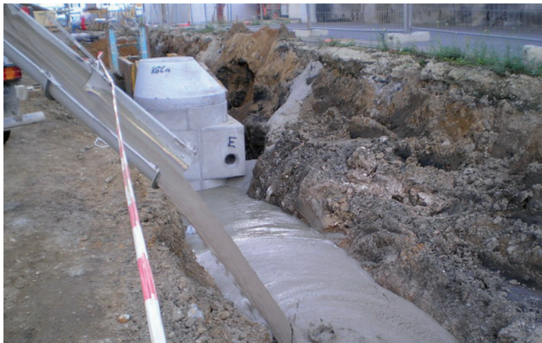
Verfüllung eines RSS Kombischachts mit RSS Flüssigboden®
