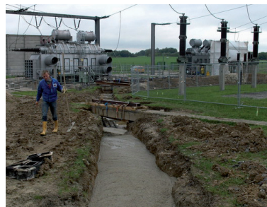
Verfüllung schwer zugänglicher Bereiche
