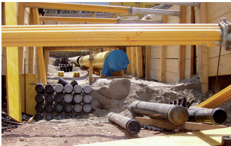
Optimale Bettungseigenschaften durch RSS Flüssigboden®
