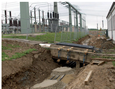
Lagesicherung mit RSS Flüssigboden® (k p )
