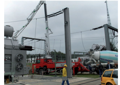
Anlieferung RSS Flüssigboden®
